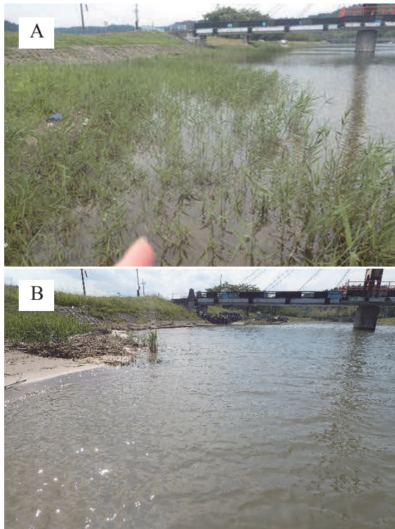
図2 震災前後の久里川尻川河口沿岸(Se.1)の比較(A:2022年8月10日撮影、B:2024年6月1日撮影)
